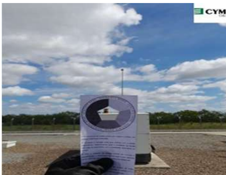
Foto 12: Ação voluntária de monitoramento de fumaça preta nos geradores das Subestações da HRZ.
