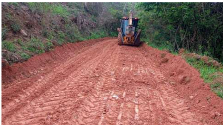
Foto 14: Vista de adequação de vias de acesso na LT SP-MG.
