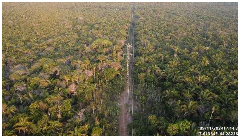
Foto 10: Vista geral de inspeção interna da HRZ com o uso de Drone.
