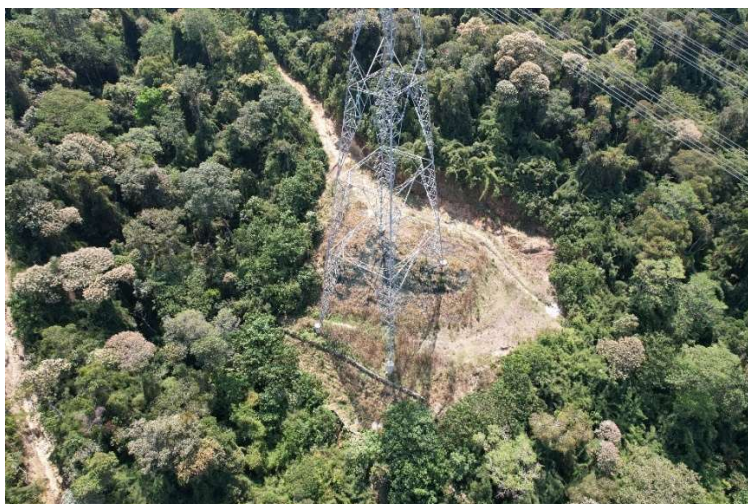
Foto 16: Vista aérea de torre na LT SP-MG, onde o monitoramento é realizado nas regiões de relevo mais acidentado durante o período chuvoso e com o uso de Drone.
