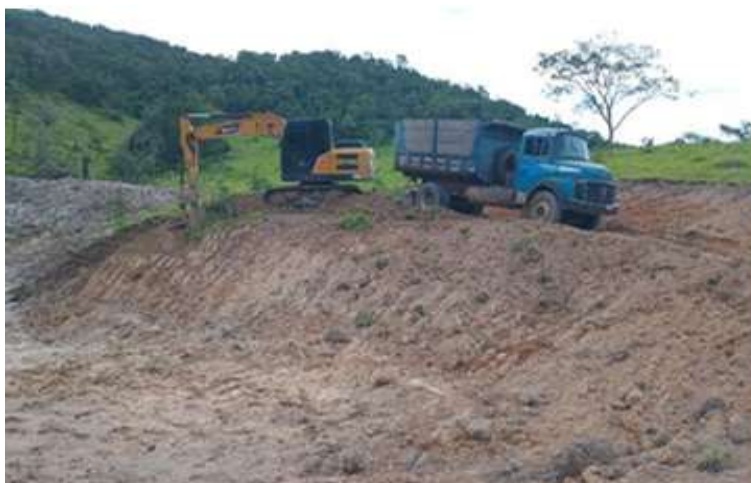
Foto 15: Vista de adequação de acessos na LT SP-MG.
