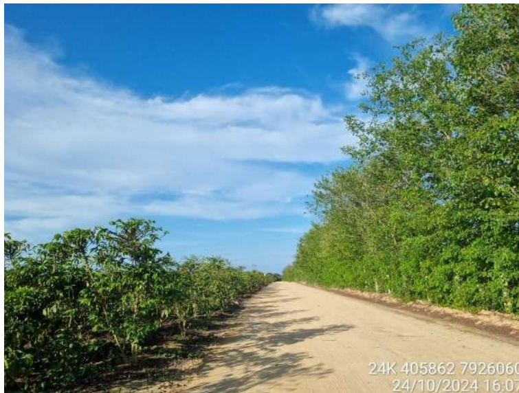
Foto 29: Vista da cortina verde instalada em parte do entorno da SE São Mateus II, LT TES.
